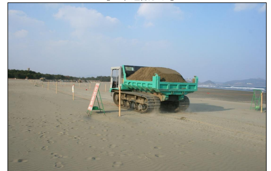
【土砂運搬状況】
