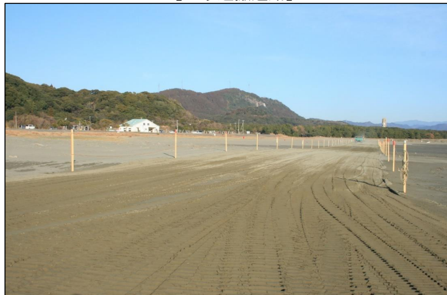
【土砂運搬通路】
